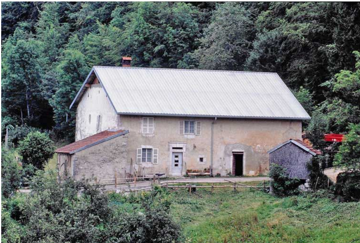
Vue éloignée de la façade antérieure.
