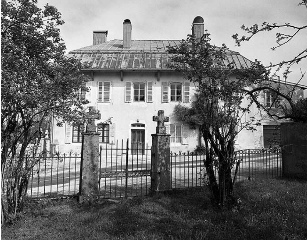
Façade antérieure vue depuis le jardin.
