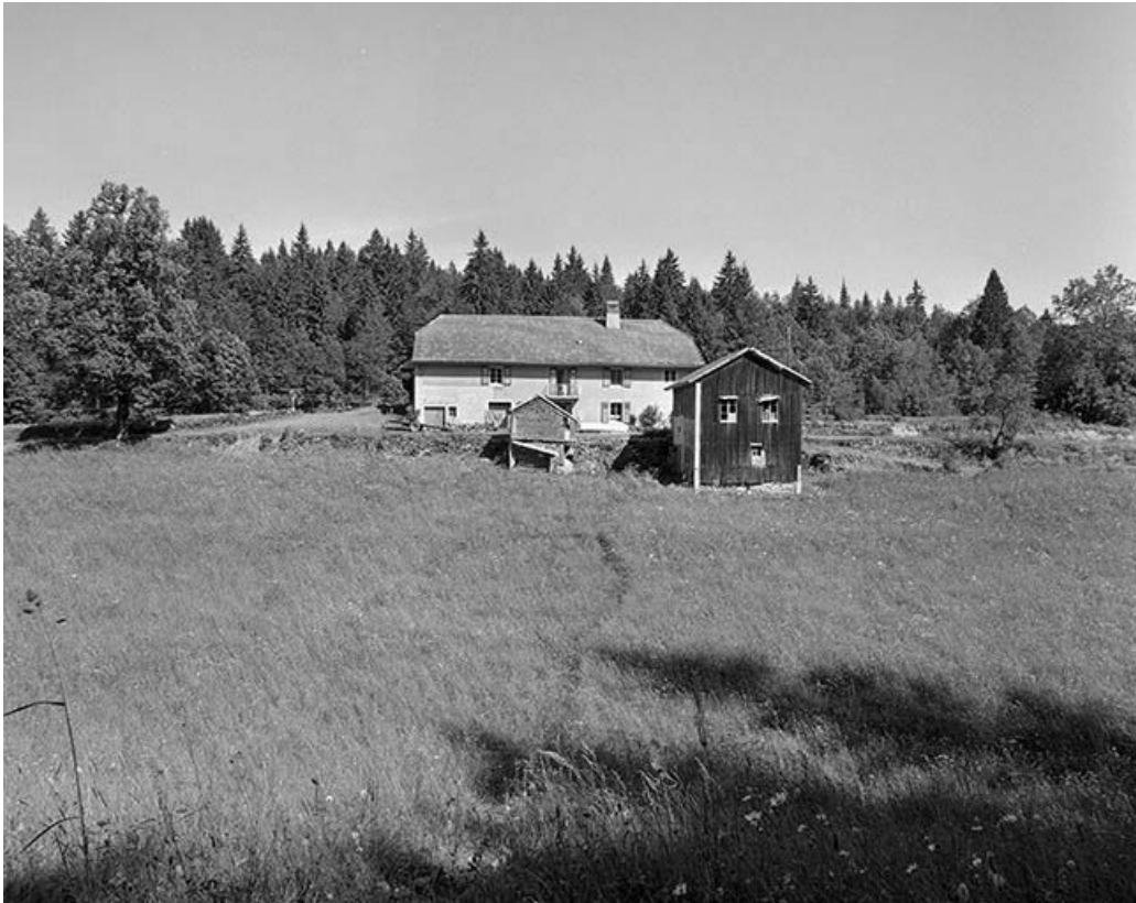
Façade antérieure, vue éloignée.
