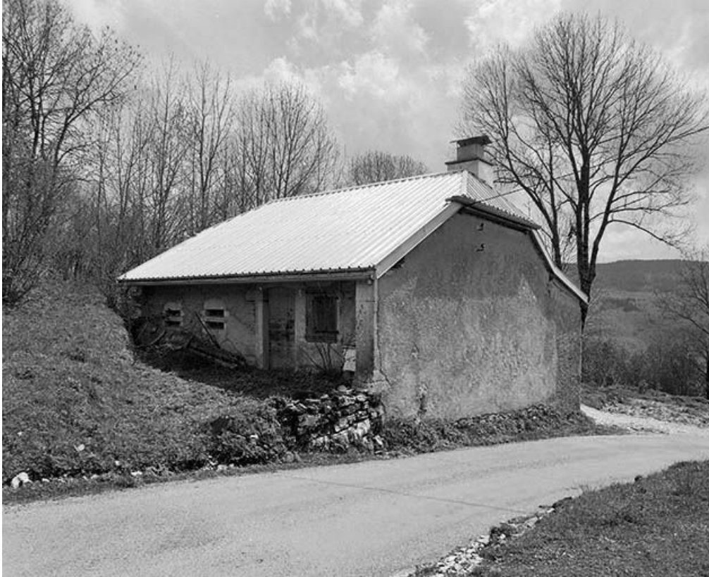
Façade antérieure et face droite.
