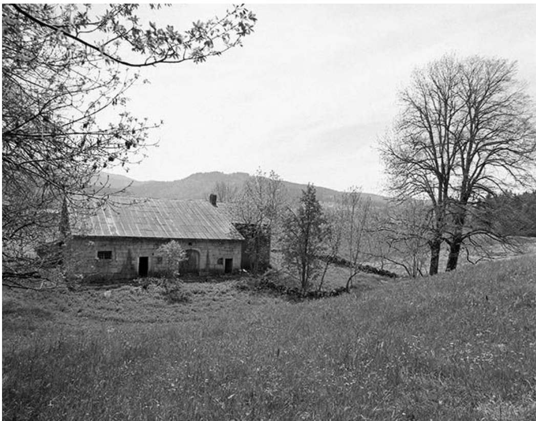
Vue éloignée de la façade postérieure.
