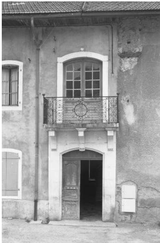
Logement patronal : porte d'entrée et balcon.
