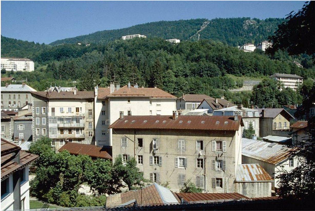
Immeuble et remise : façade sur la Bienne.
