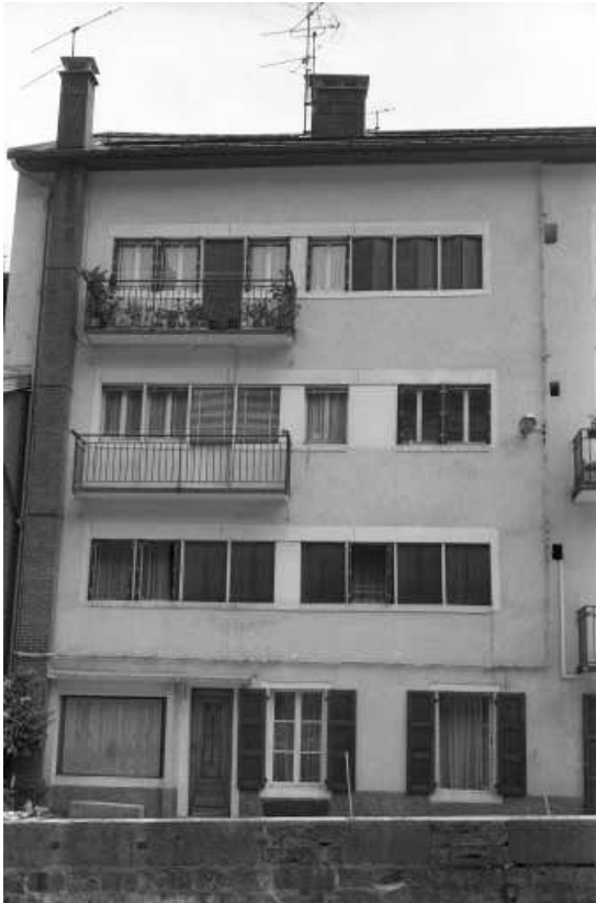
Détail de la façade latérale gauche.
