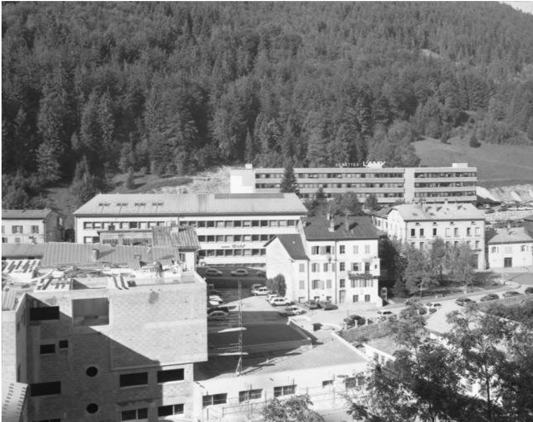
Site récent : vue d'ensemble.
