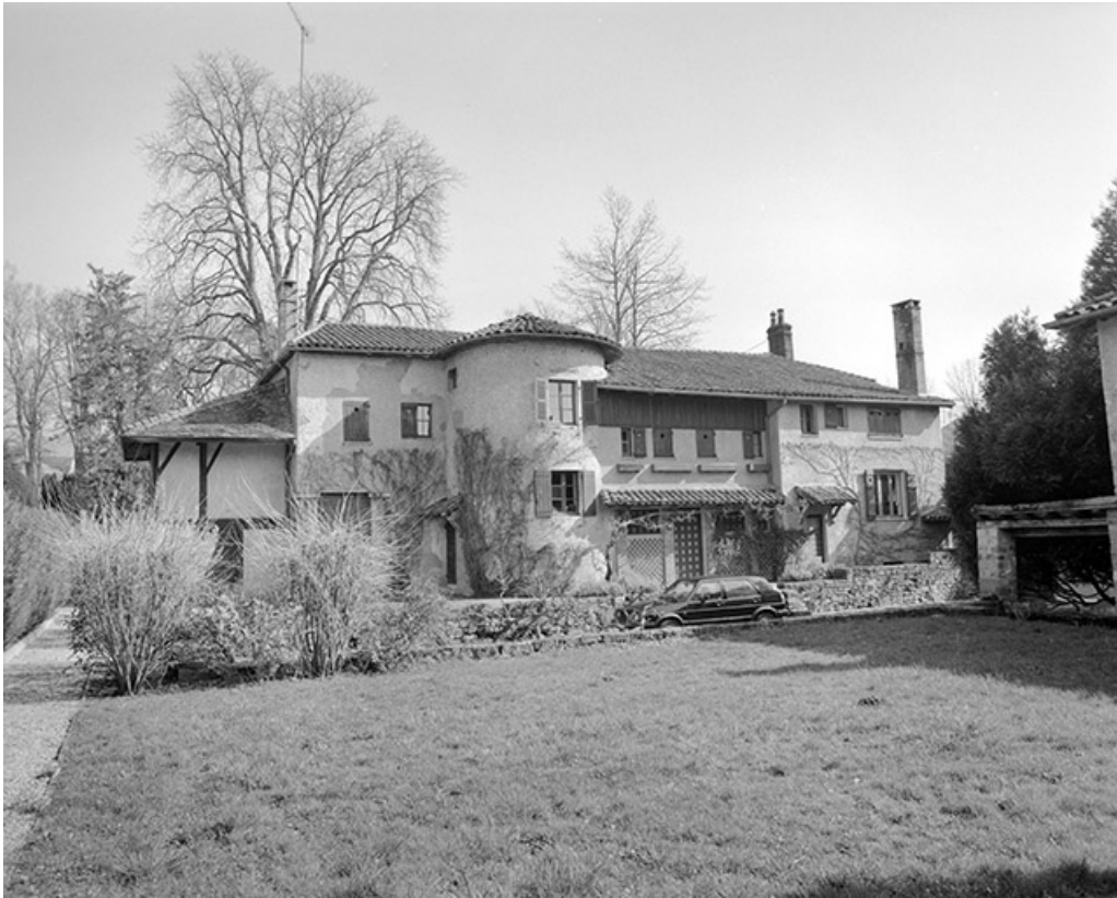
Façade antérieure du logement patronal (O).
