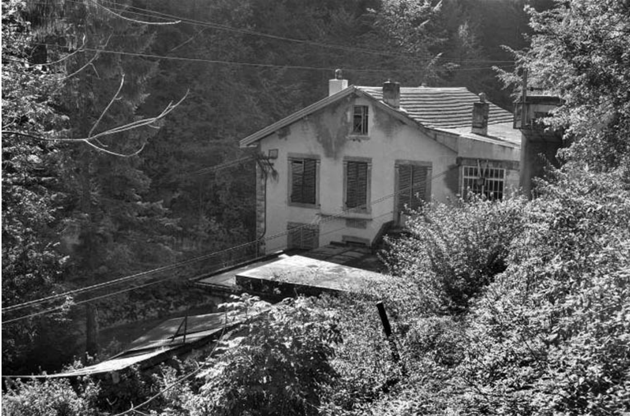
Façade antérieure, vue en plongée.
