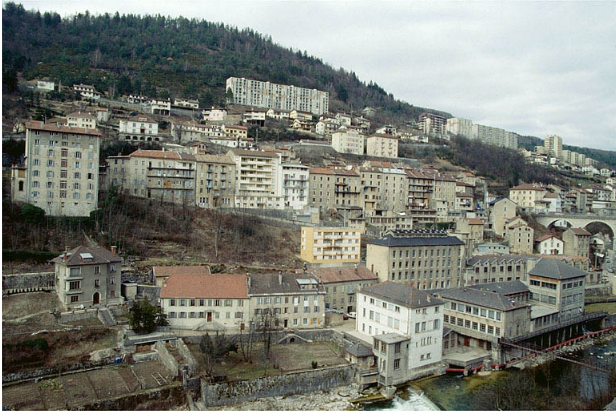
Vue d'ensemble du site depuis le sud-est.
