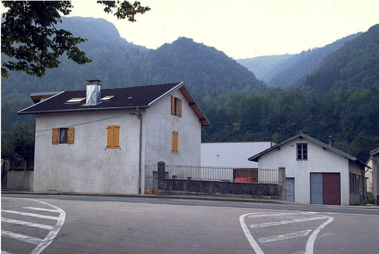
Entrée de l'usine.
