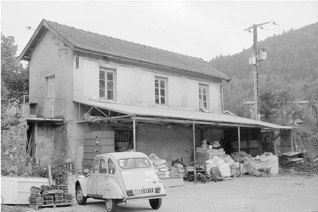
Ancien atelier de fabrication.
