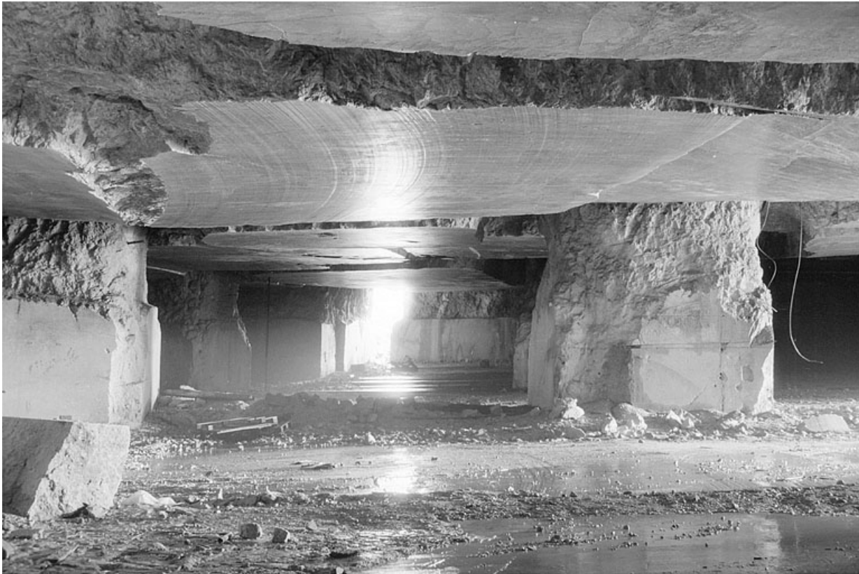
Carrière souterraine de Chassal : galerie latérale. 39, Molinges
