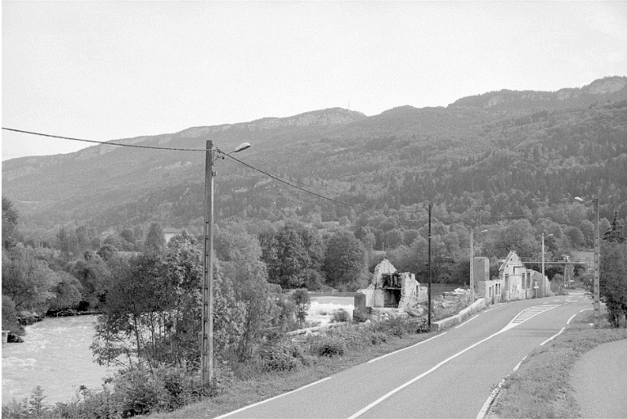
Usine de Molinges : vestiges.
