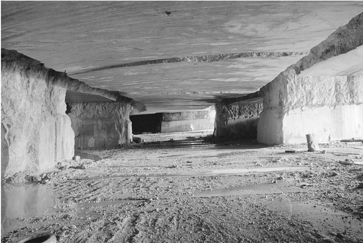
Carrière souterraine de Chassal : galerie latérale. 39, Molinges
