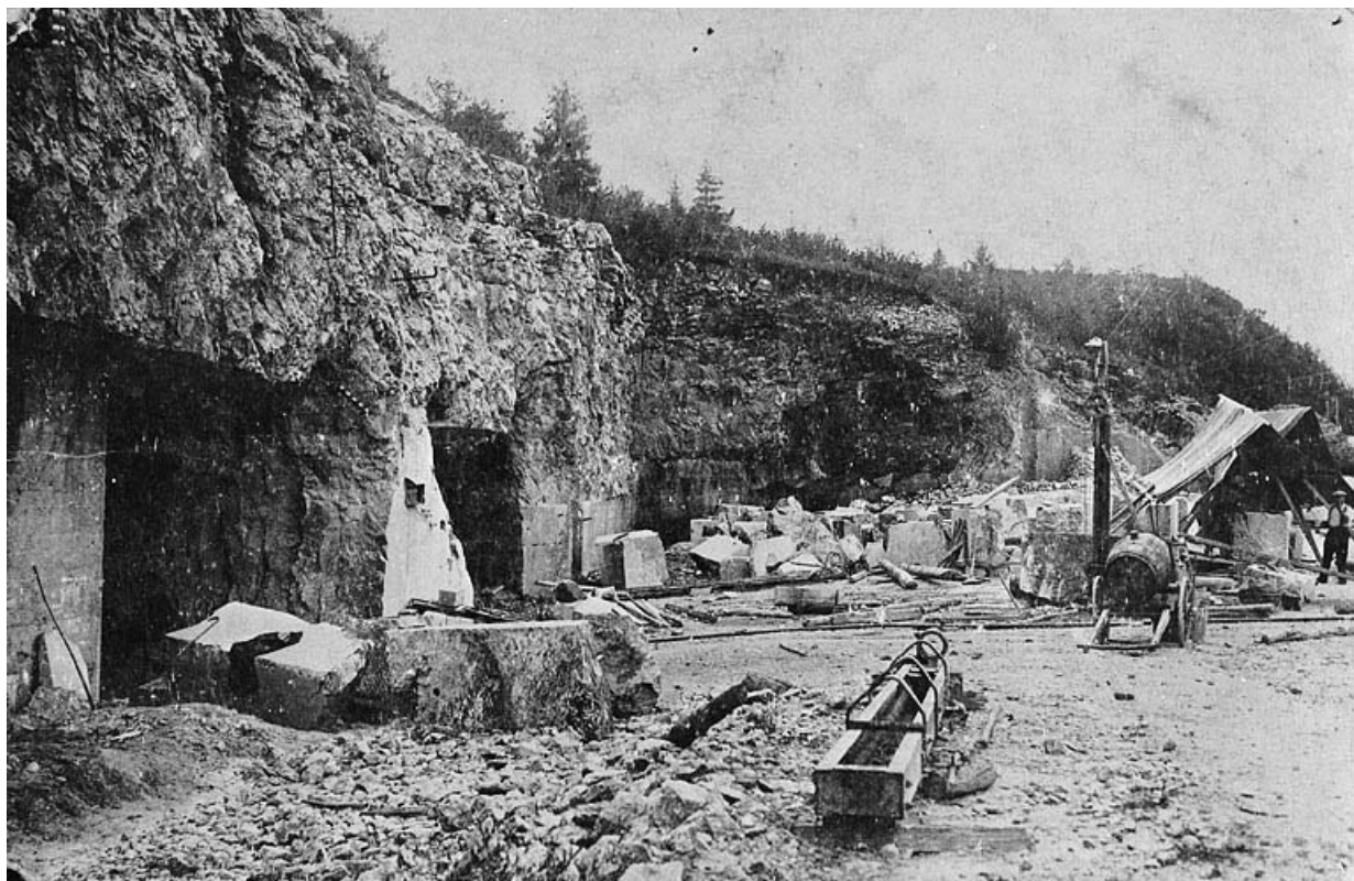
Chantier et entrées de la carrière souterraine.
