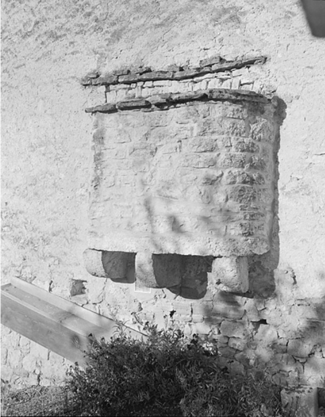
Four accolé en pignon, porté par des consoles en pierres. 39, La Rixouse
