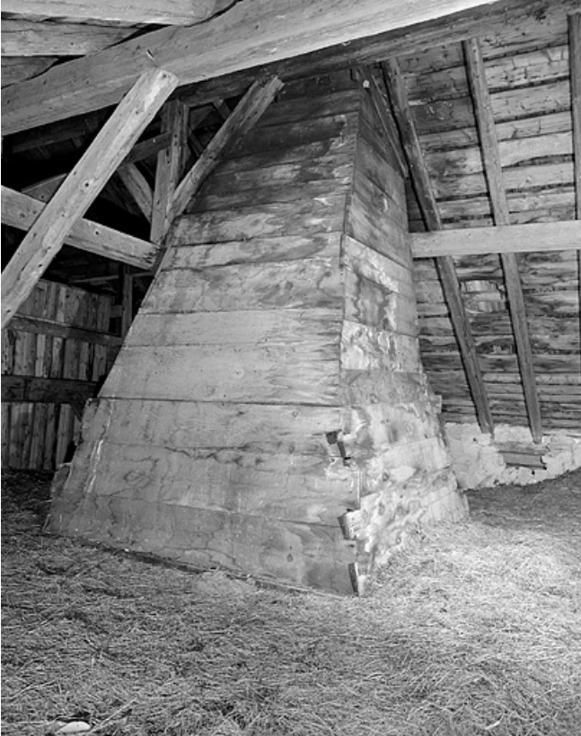
La cheminée en bois dans les combles.
