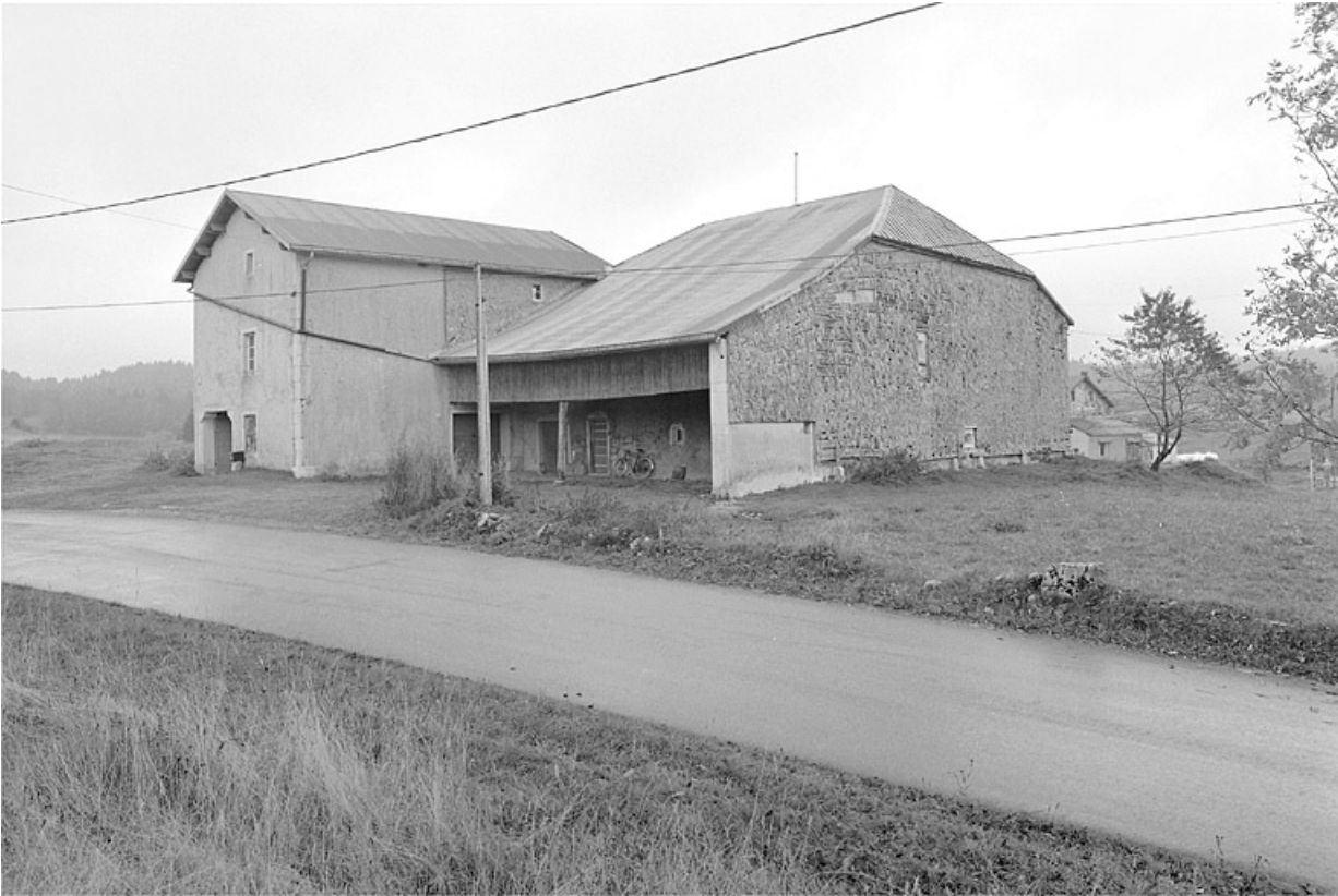
Façade postérieure et face ouest.
