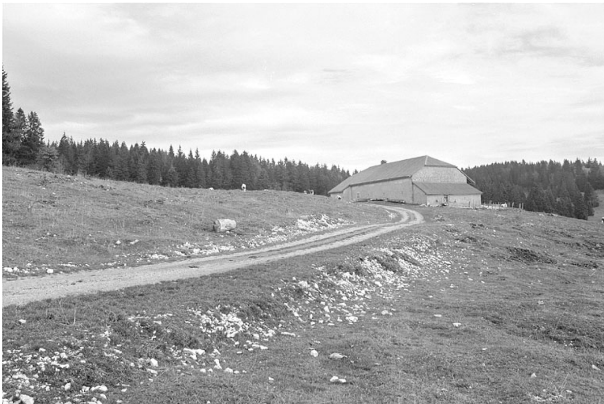
Vue générale depuis le chemin d'accès.
