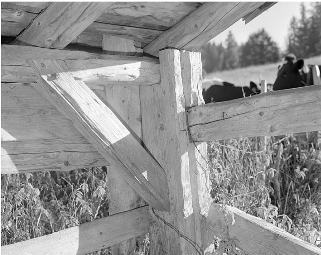
Assemblage de la charpente de l'abreuvoir.
