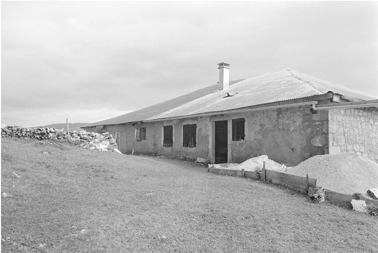
Façade postérieure, vue de trois quarts droit.
