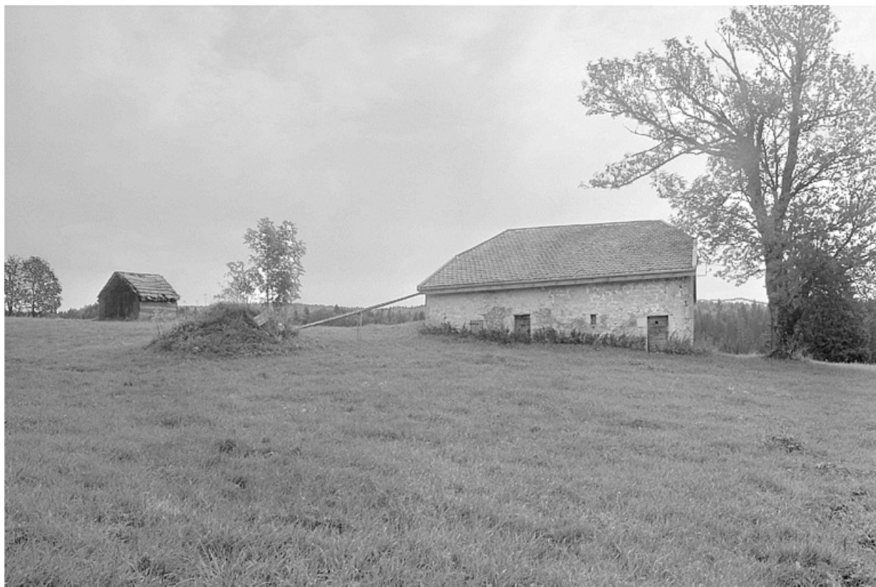
Vue générale, ferme et grenier fort.
