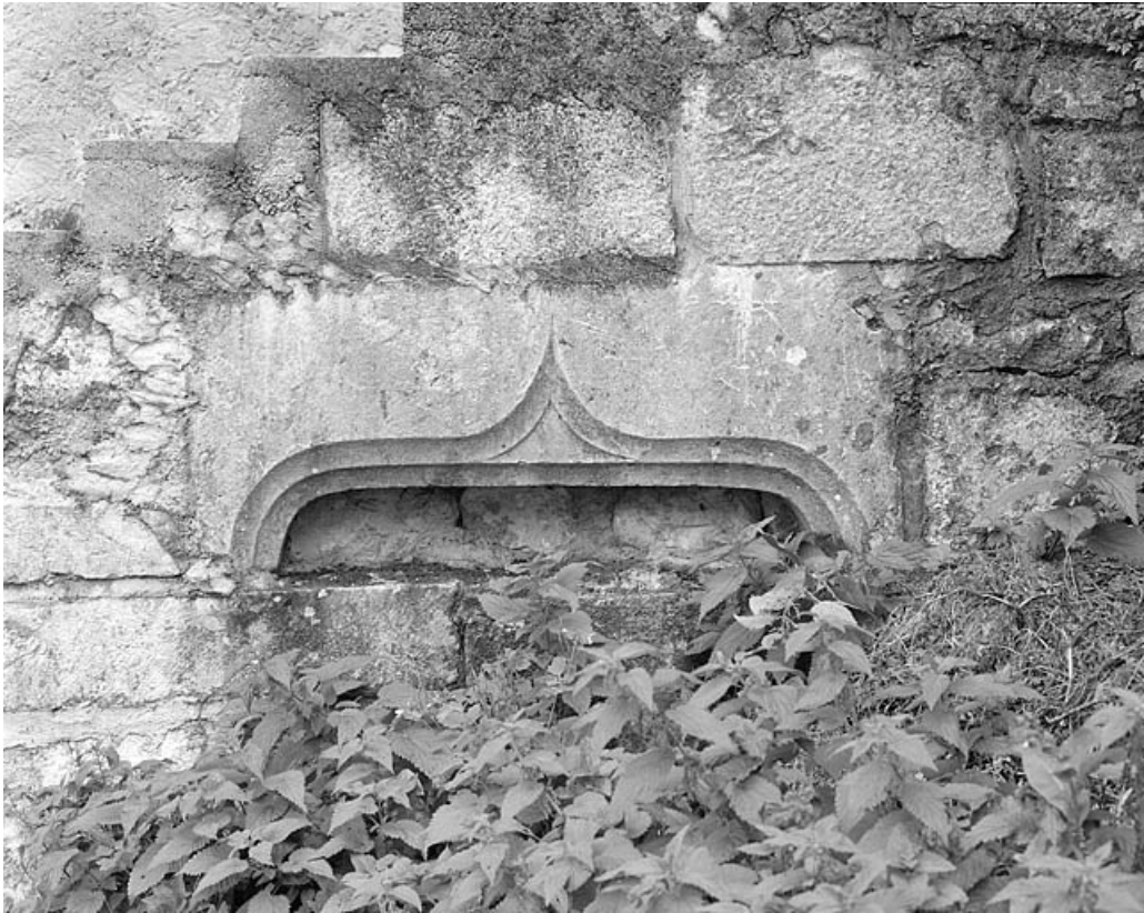
Linteau en accolade réemployé.
