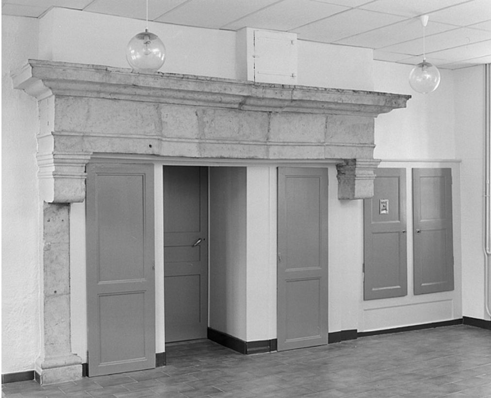
Cheminée dans l'ancienne cuisine au rez-de-chaussée.
