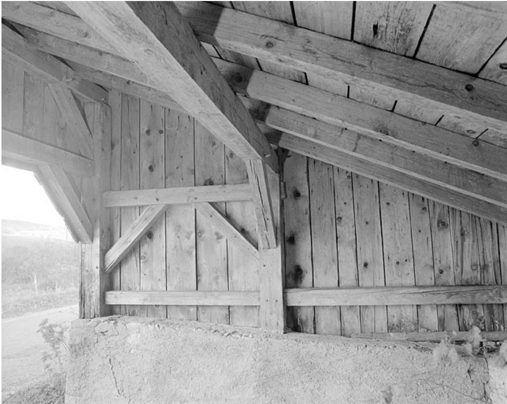
Détail de la charpente.
