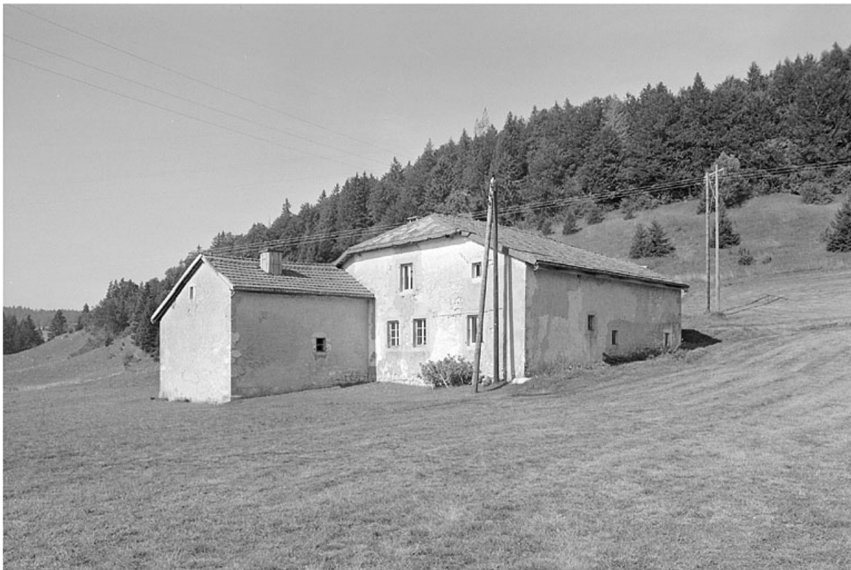
Face sud-est et façade postérieure.
