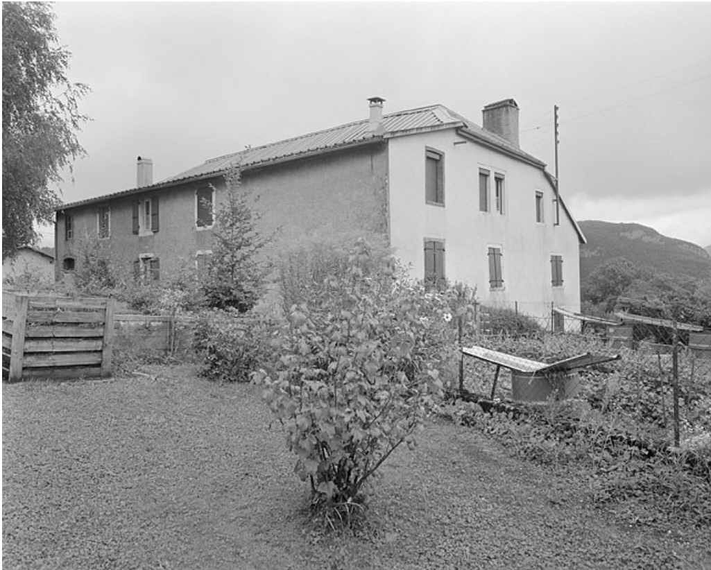
Façade postérieure et face sud.
