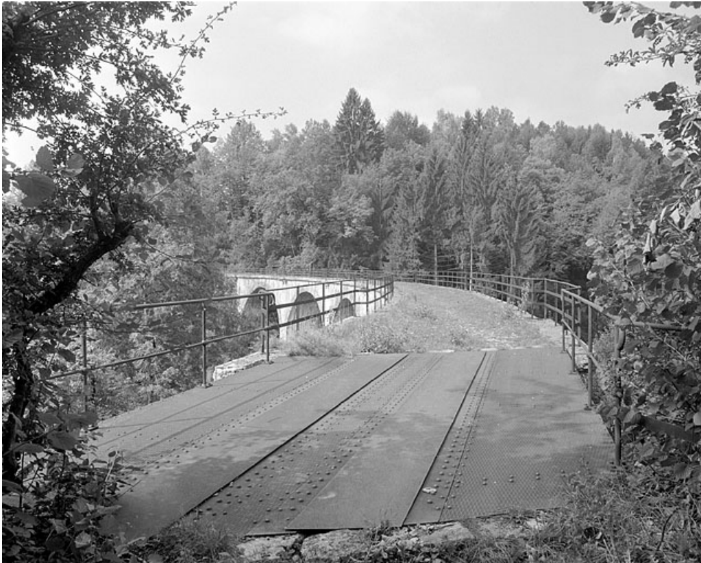
Tablier du viaduc.
