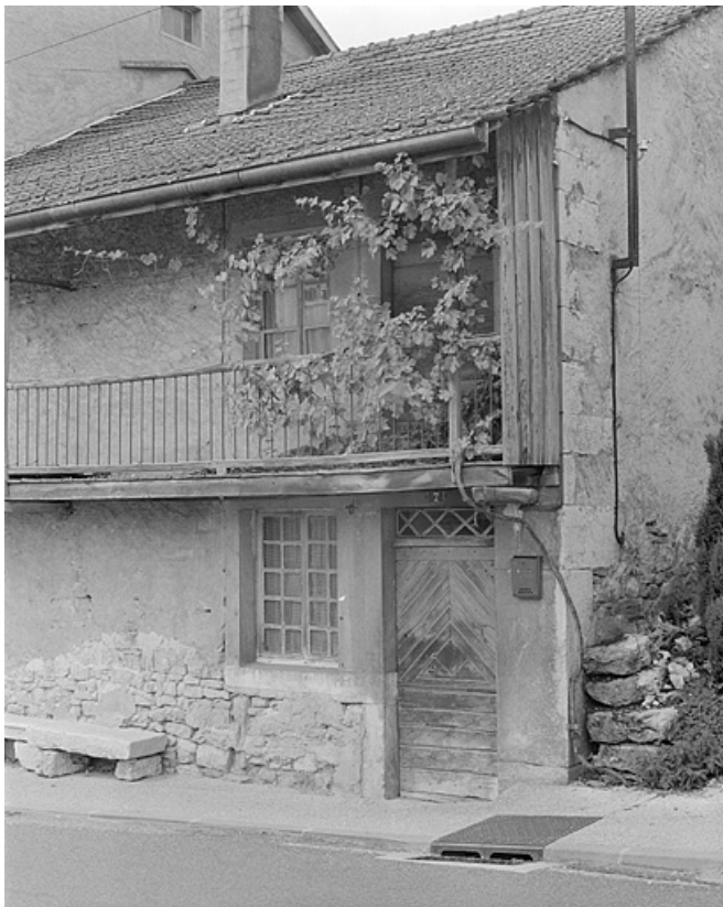
Partie droite de la façade antérieure.
