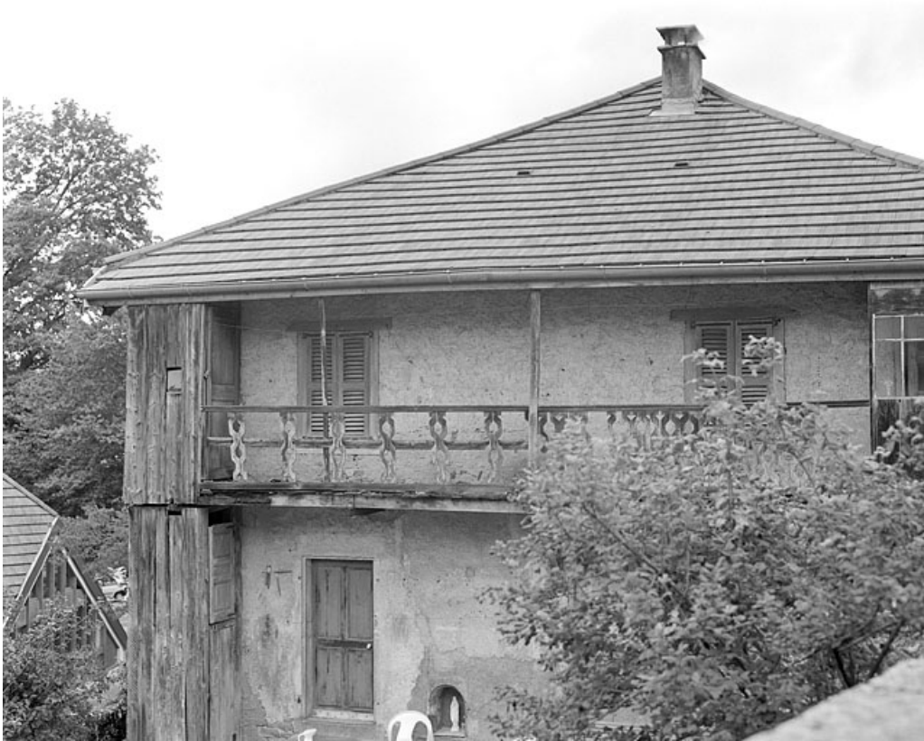
Balcon en galerie sur la façade antérieure.
