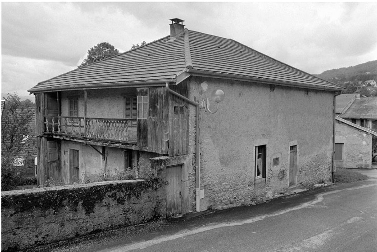
Façade antérieure et face droite.
