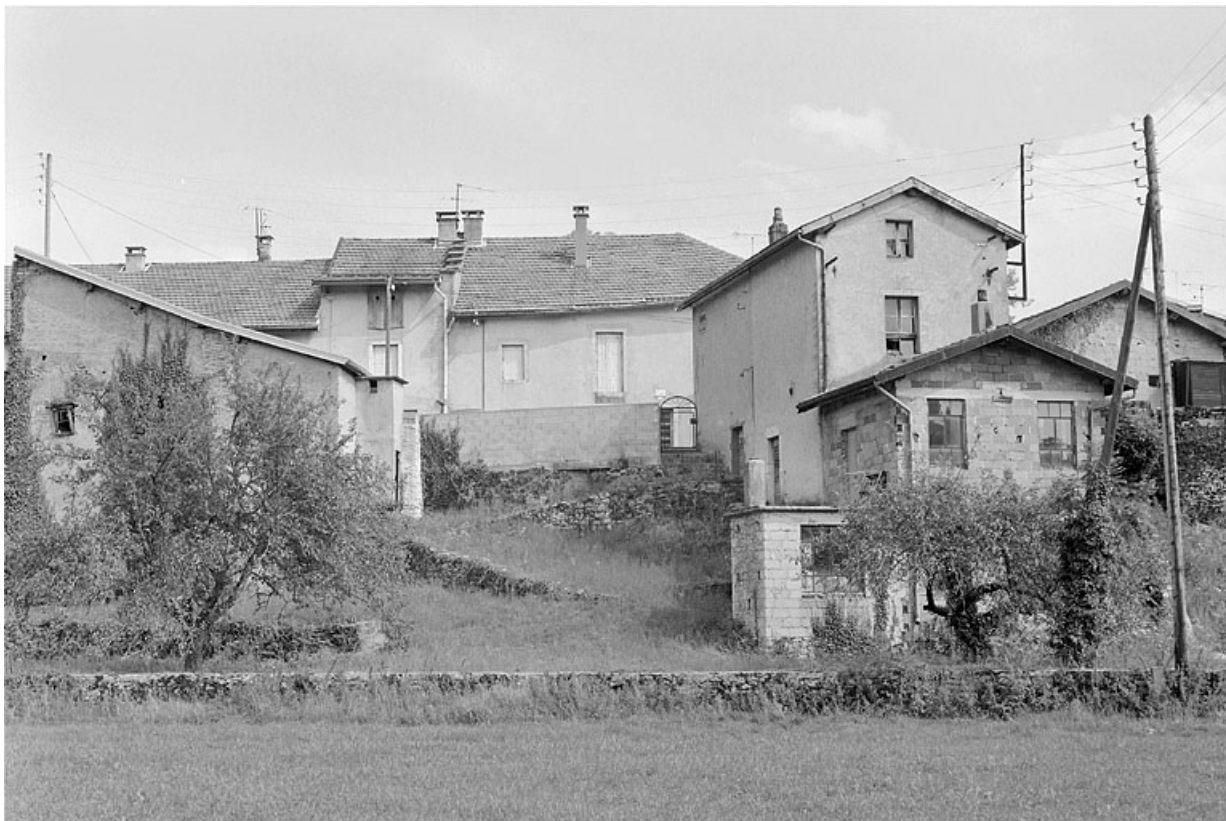
Vue postérieure de l'atelier de pipes.
