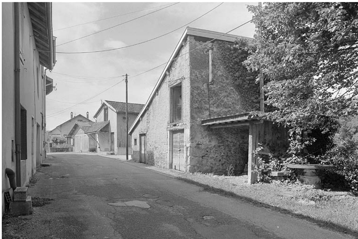
Bâtiment de stockage des ébauchons.
