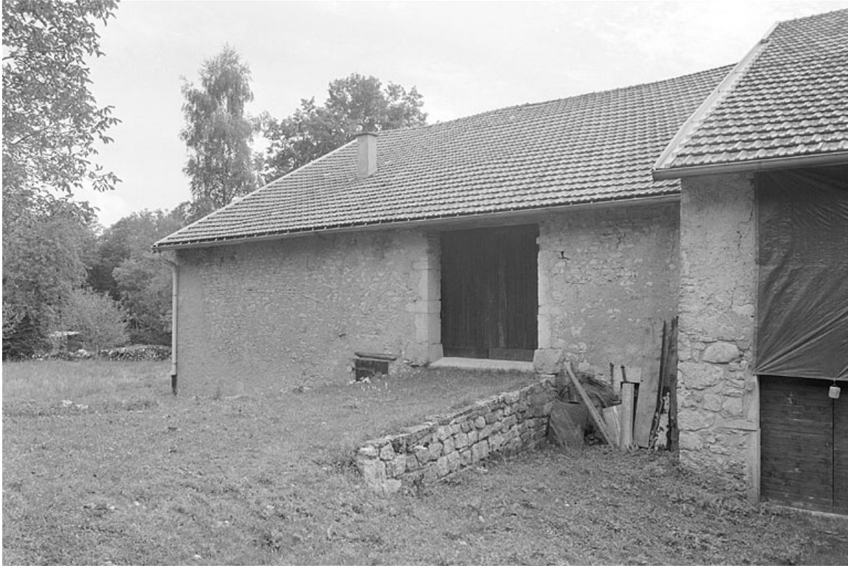
Façade postérieure, grange haute.
