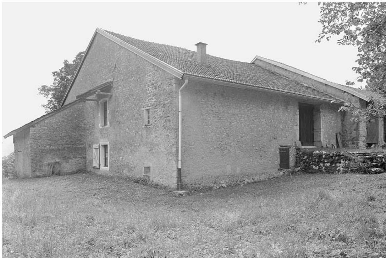
Face droite et façade postérieure.
