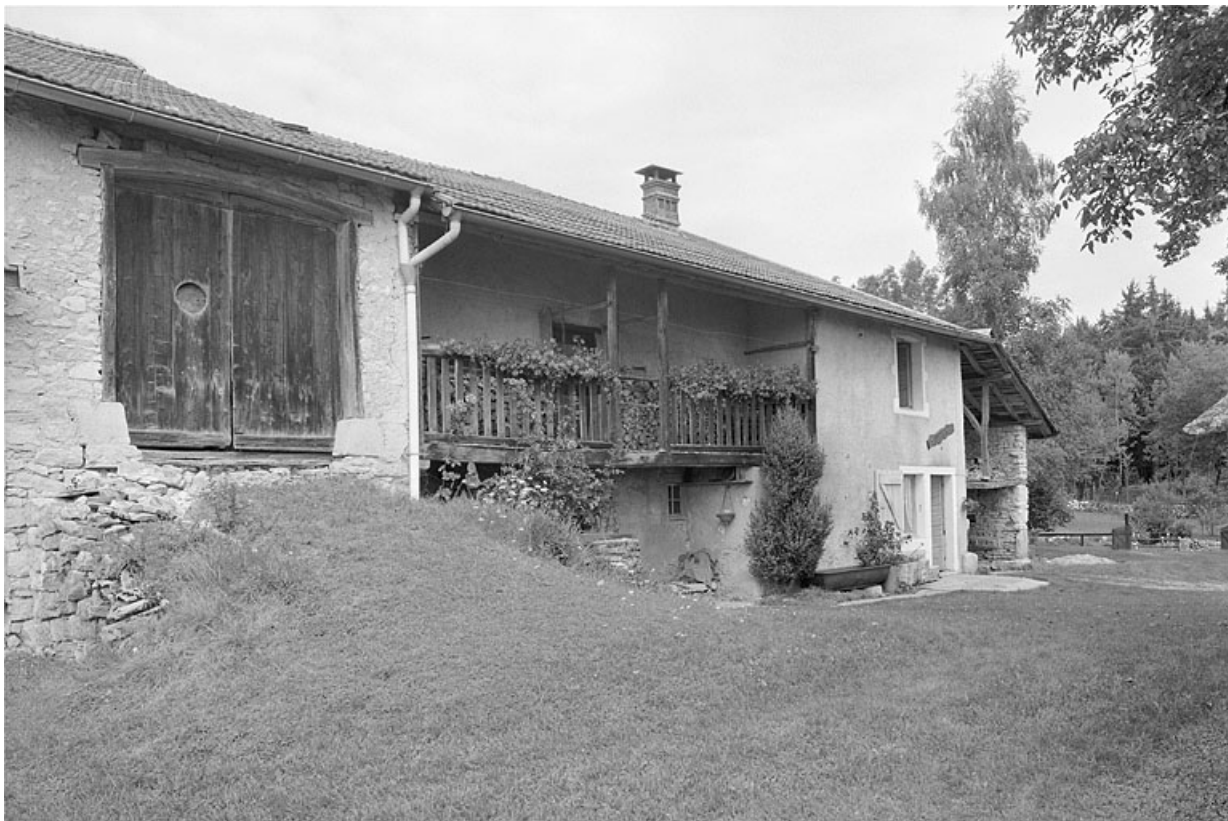
Façade antérieure, balcon en galerie.
