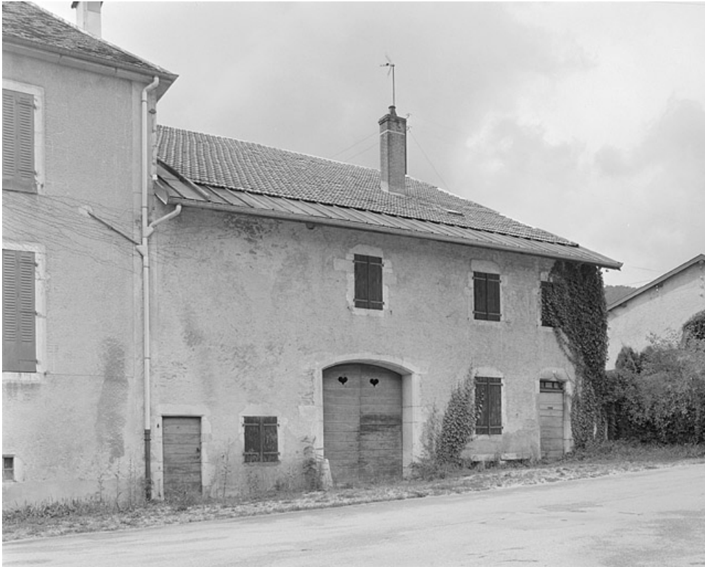
Face nord-est de la ferme.
