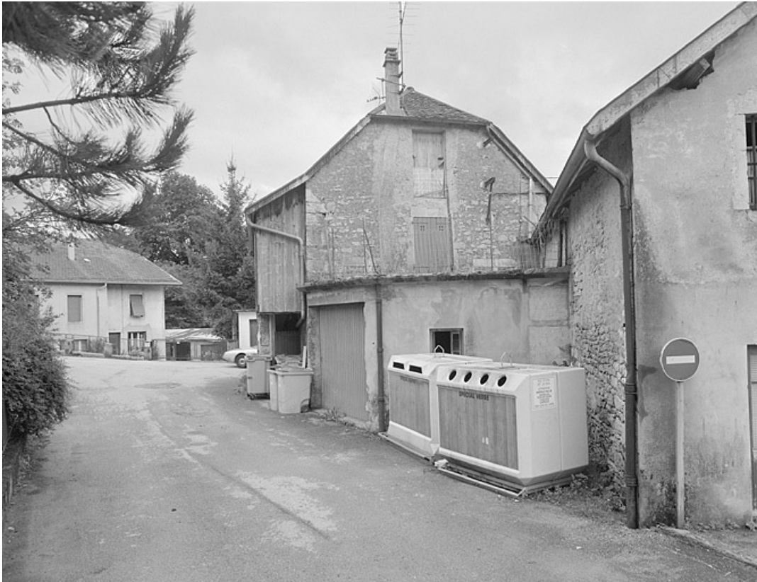
Face droite de l'ancienne fromagerie.
