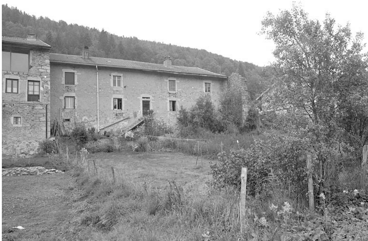
Façade postérieure, vue générale.
