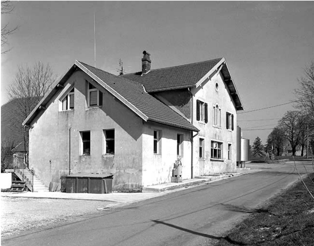
Façade sur rue de trois quarts gauche.
