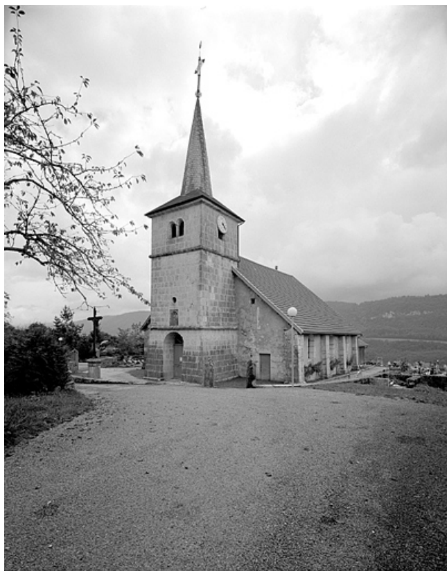
Façade antérieure et face droite.
