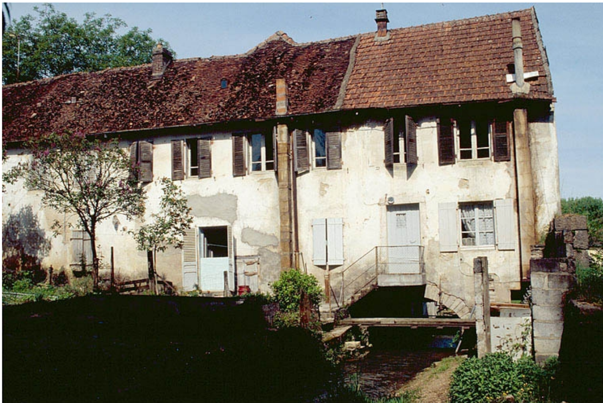
Bâtiment d'eau et logement depuis le sud-est.
