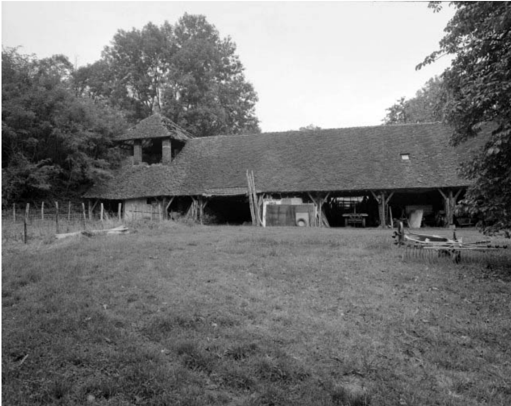
Four industriel et pièce de séchage.
