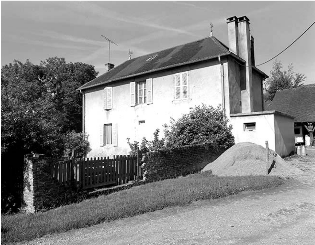
Façade postérieure du logement patronal.
