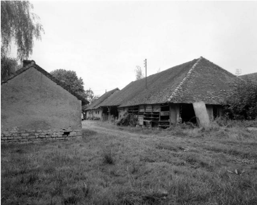
Atelier de fabrication depuis le nord.
