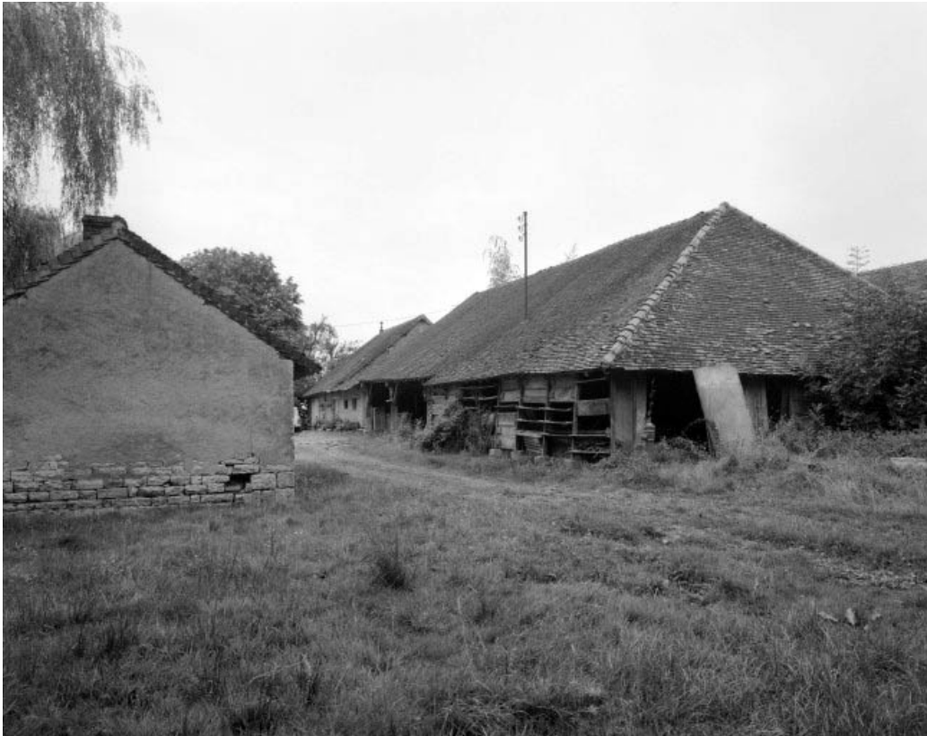
Atelier de fabrication depuis le nord.
