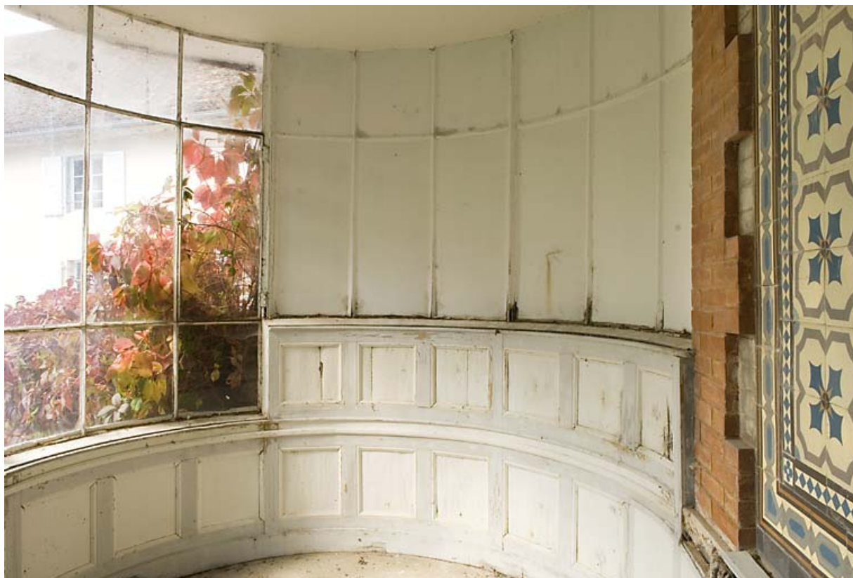
Serre : intérieur (extrémité nord-ouest).
