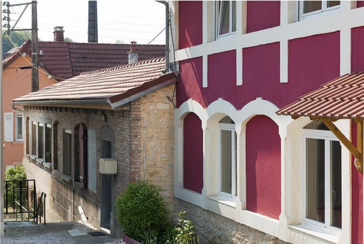
Façade sud des ateliers.
