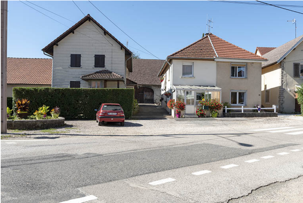
Vue d'ensemble, depuis la rue (au nord).
