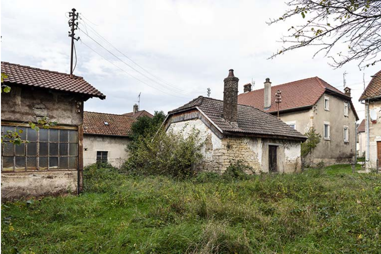
Forge : façades postérieure et latérale gauche.
