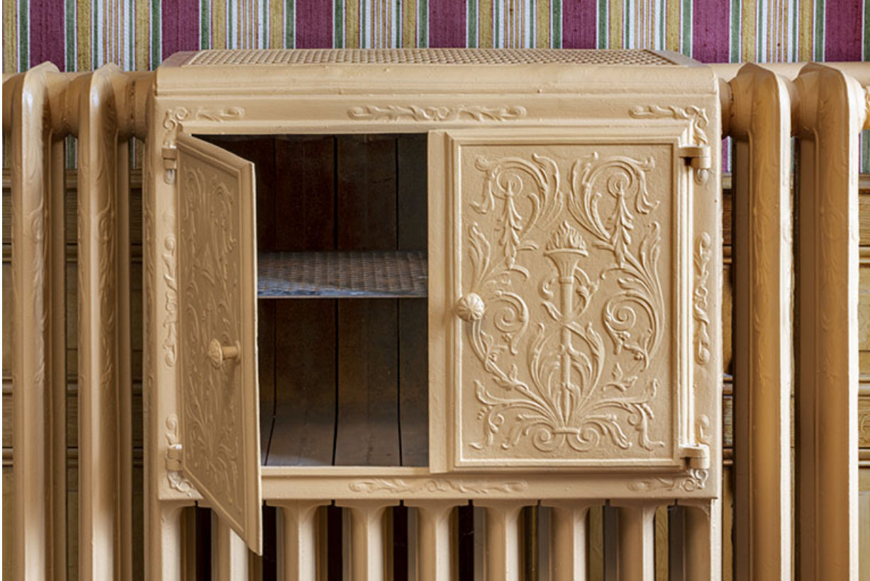
Maison, salon : chauffe-plat du radiateur.
