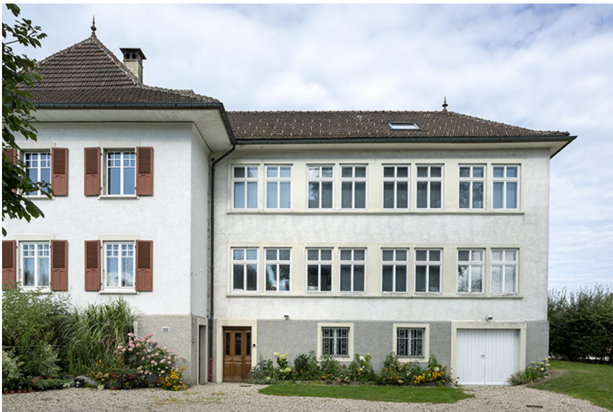
Usine : façade antérieure.
