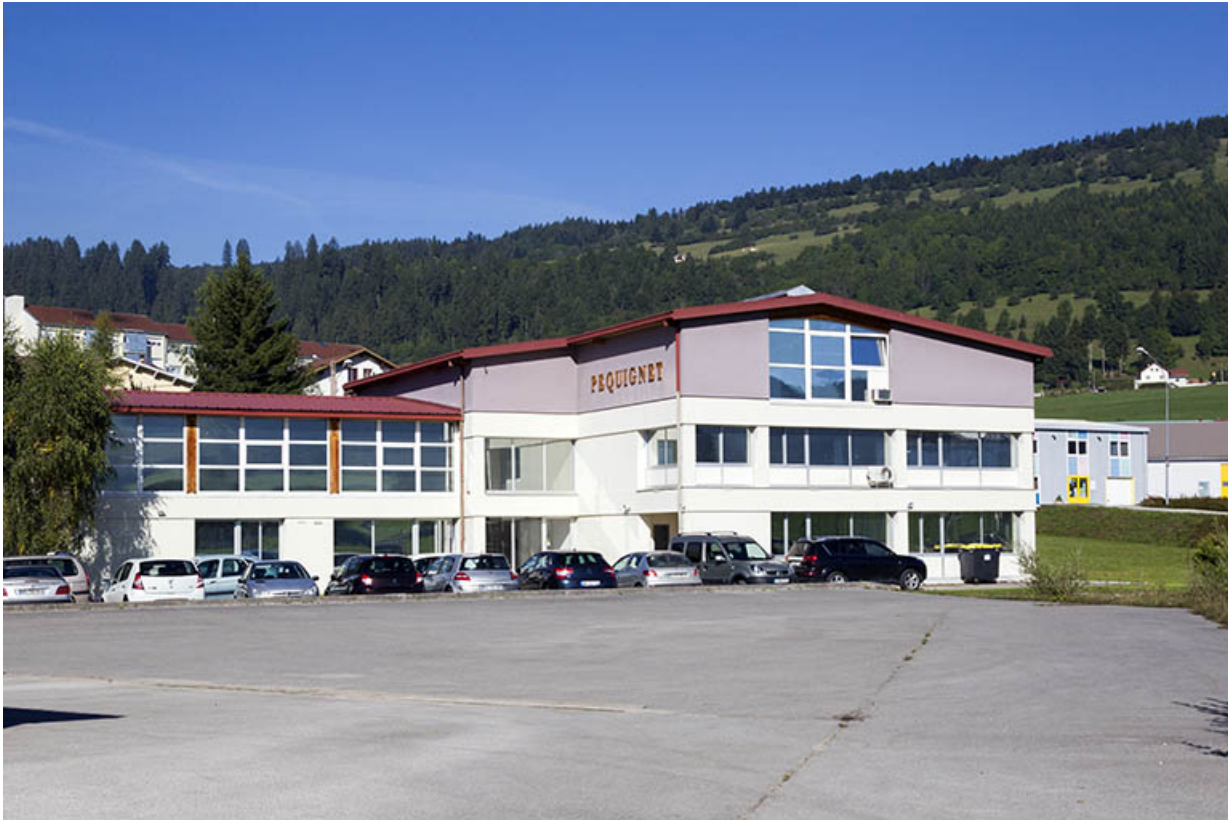
Façade latérale droite, de trois quarts gauche.
