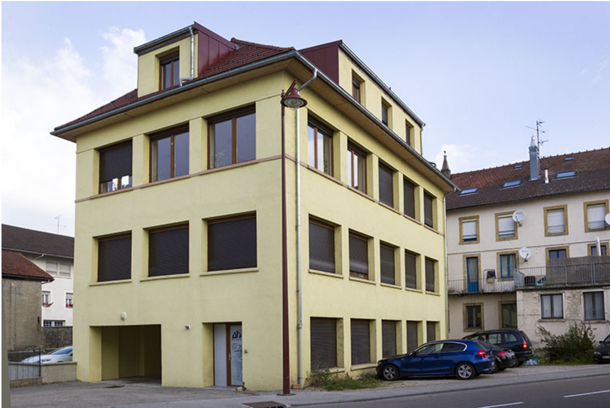
Atelier, depuis le sud-est.
