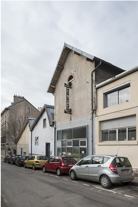
Pignons-est des bâtiments sur la rue.
