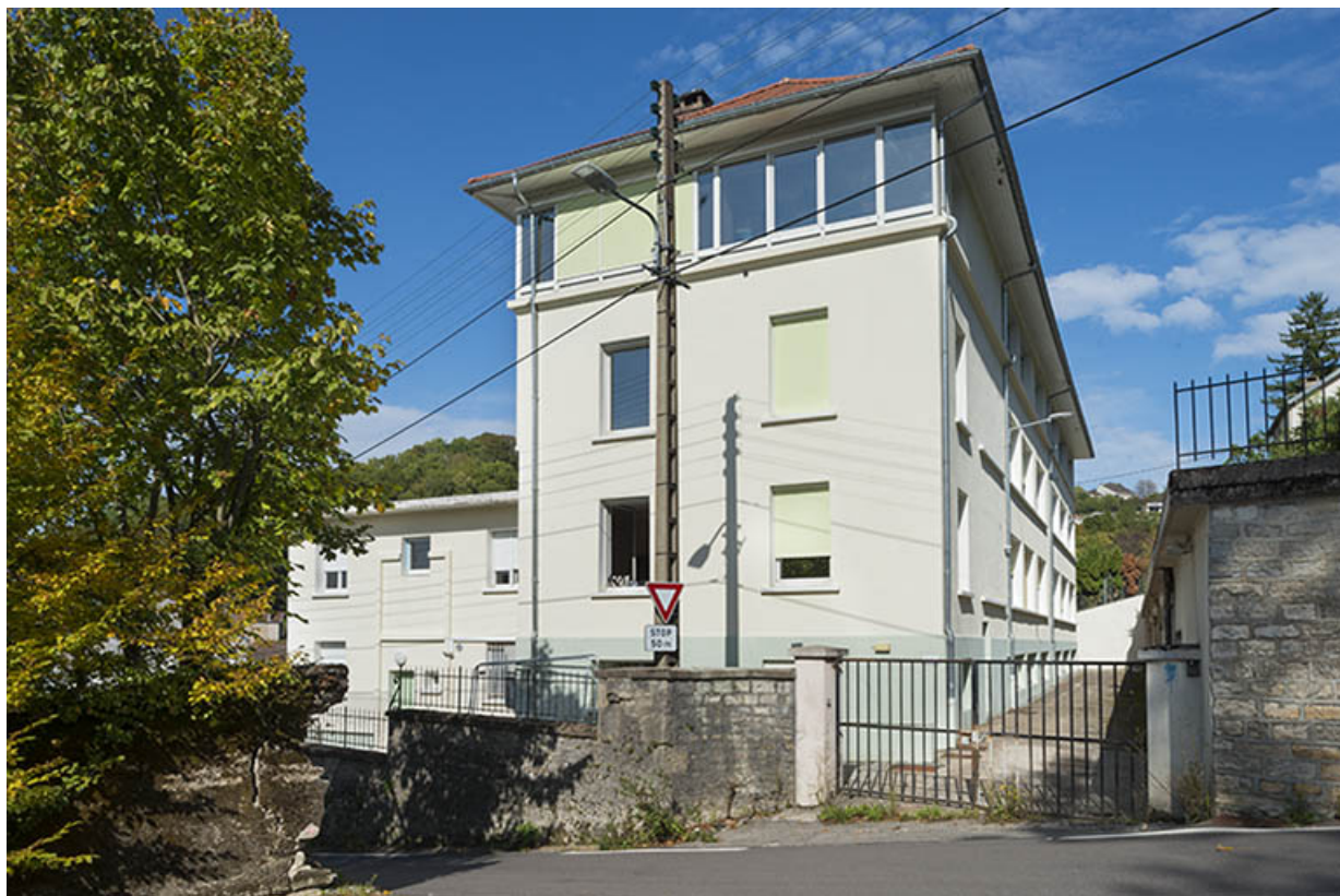
Pignon ouest et façade postérieure.
