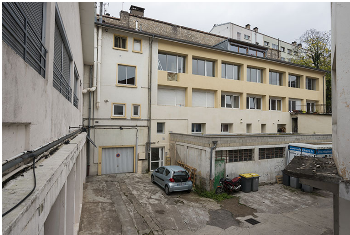
Façade ouest d'un atelier sur cour (4B).
