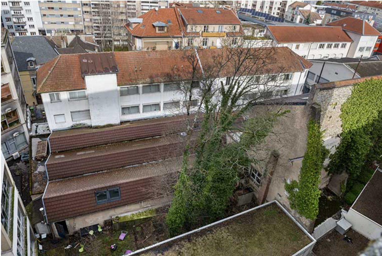
Vue plongeante depuis le sud.
