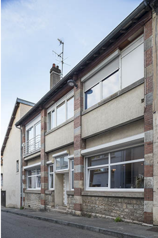
Façade antérieure vue de trois quarts droite.
