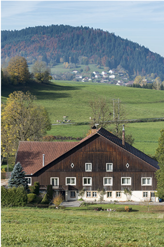
Façade latérale droite (est).
