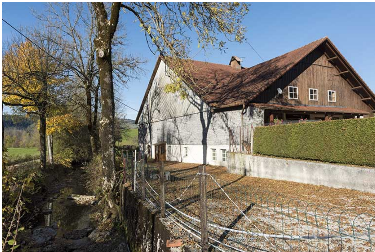
Façades antérieure et latérale gauche (ouest).
